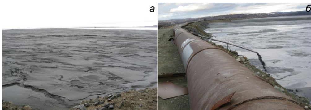
Рис. 14. Хвостохранилище обогатительной фабрики № 1 медно-никелевого комбината «Печенганикель»: а — зона пляжа; б — намыв хвостов
